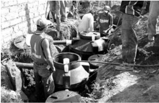
» Instalación de baños con biodigestor.
