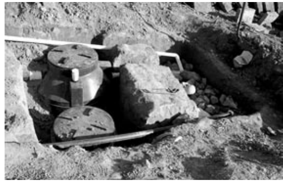
» Instalación de baños con biodigestor.
