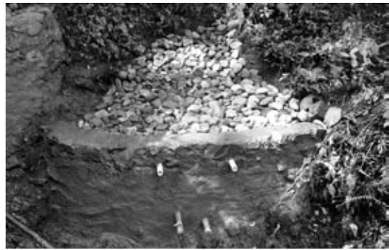
» Proceso de construcción de las galerías filtrantes.
